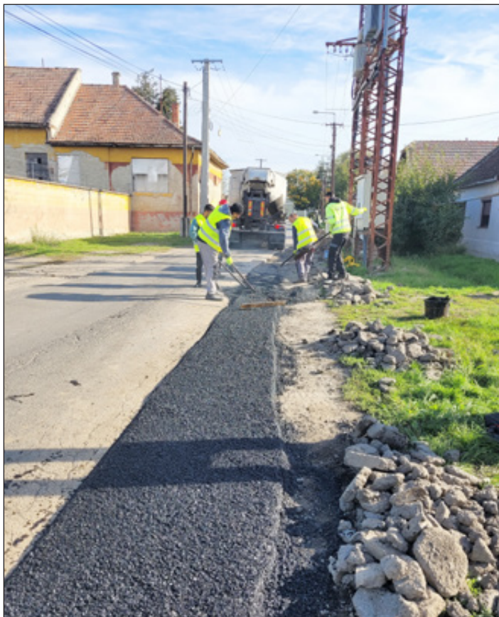
Belterületi utak nagyobb felületű aszfalt javítás. Czobor utca, Téglagyár utca, Szőlő utca, Borpince utca. Közel 130m 2 -re került melegaszfalt burkolat
