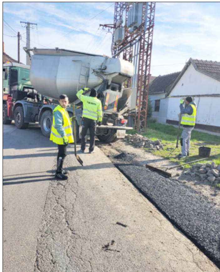
Belterületi utak nagyobb felületű aszfalt javítás. Czobor utca, Téglagyár utca, Szőlő utca, Borpince utca. Közel 130m 2 -re került melegaszfalt burkolat
